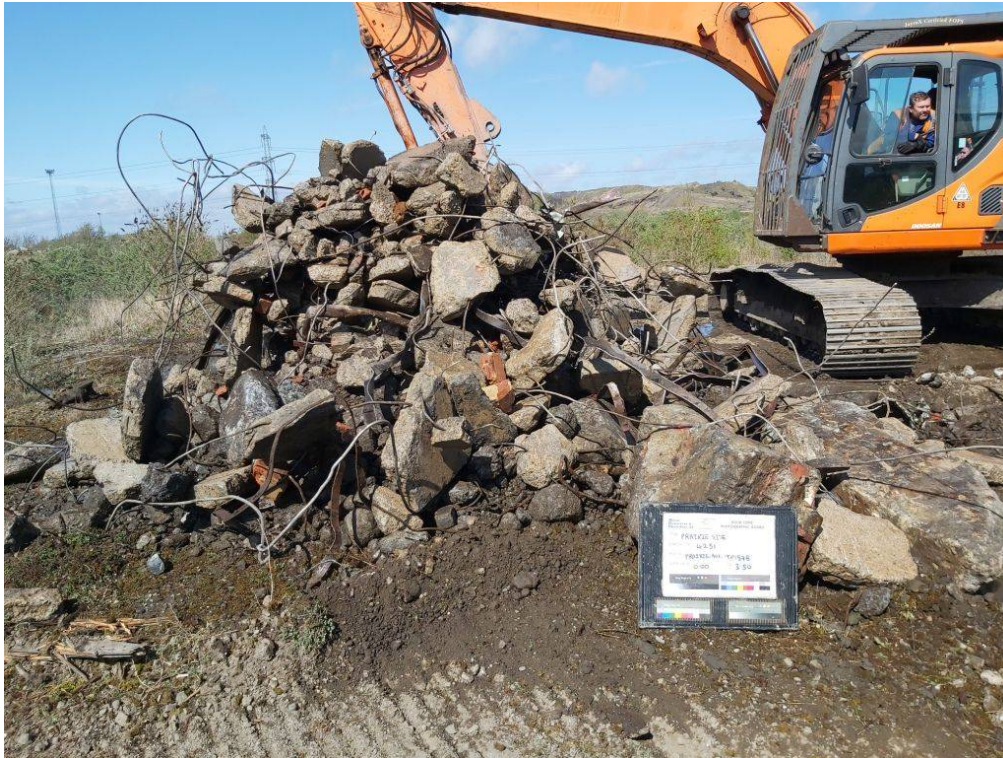
Figure PRAIRIE_AUK_TP157B.3 PRAIRIE_AUK_TP157B - Spoil
