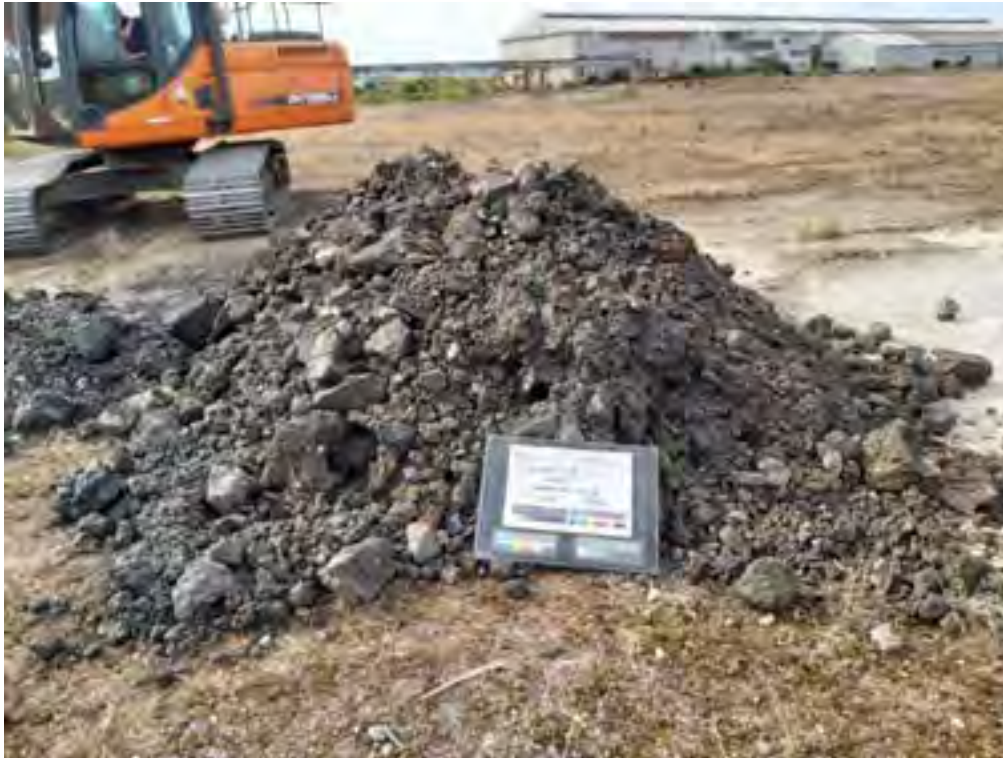
Figure PRAIRIE_AUK_TP117.3 PRAIRIE_AUK_TP117 - Spoil
