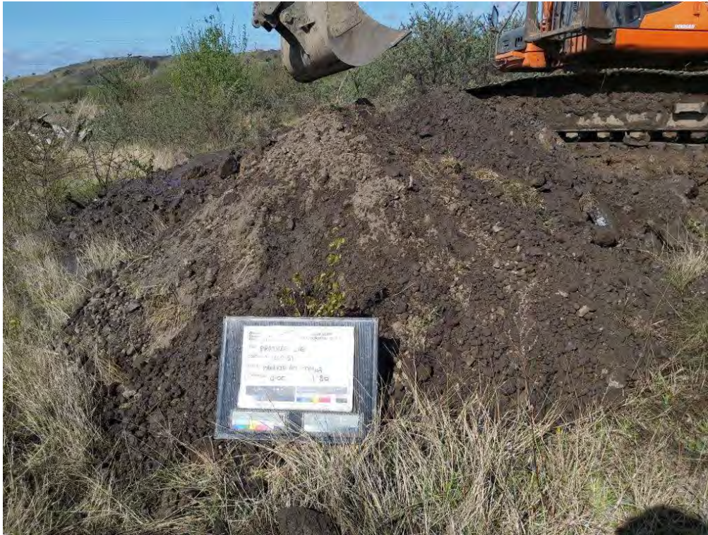
Figure PRAIRIE_AUK_TP147.3 PRAIRIE_AUK_TP147 - Spoil
