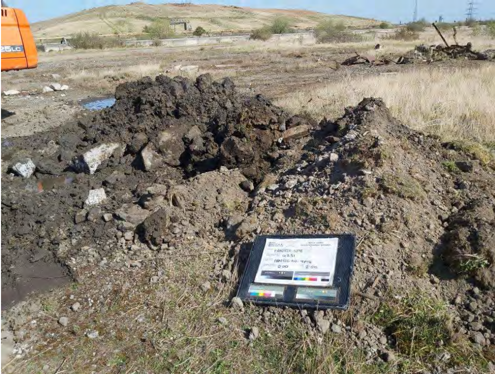
Figure PRAIRIE_AUK_TP114.3 PRAIRIE_AUK_TP114 - Spoil
