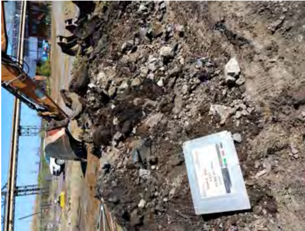
Figure PRAIRIE_AUK_TP171.3 PRAIRIE_AUK_TP171 - Spoil
