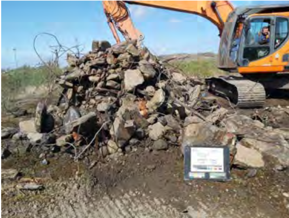
Figure PRAIRIE_AUK_TP157B.3 PRAIRIE_AUK_TP157B - Spoil
